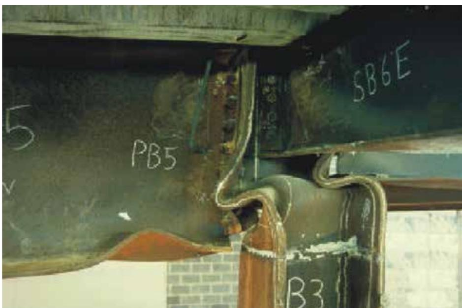
*Condizioni di una struttura metallica dopo l'esposizione ad un incendio reale.*
